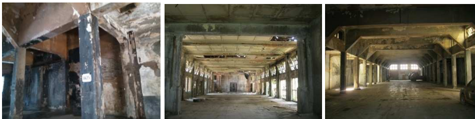
Gambar 8. Kondisi eksisting Gedung PT. Kerta Niaga Saat ini Sumber : Dokumentasi Penulis
